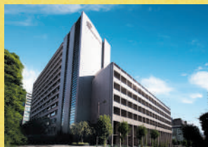
本館E・F棟
