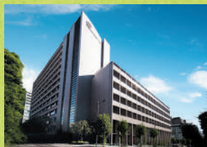
本館E・F棟
